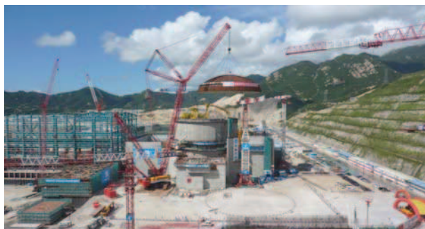
Levage du dôme de l'unité 2, 12 septembre 2012
